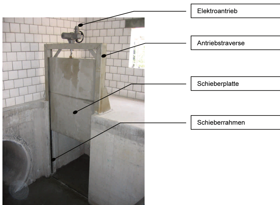
Fig. 5.4 - Typische Anordnung Elektroantrieb
